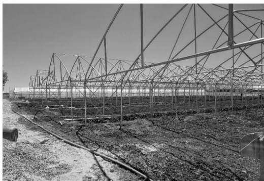
Fig. 1. Solarii în construcție
